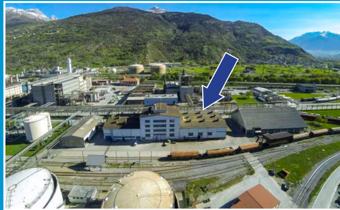
Ammonsalpeter-Produktionsgebäude mit Lose-Lagerhalle und Bahnverlad.
